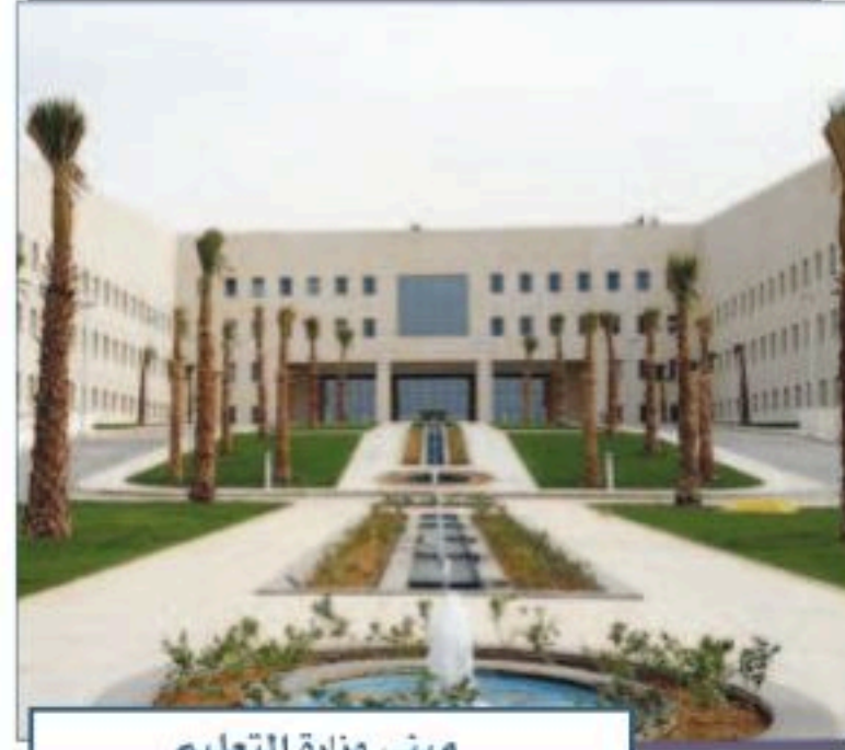
مبنى وزارة التعليم
