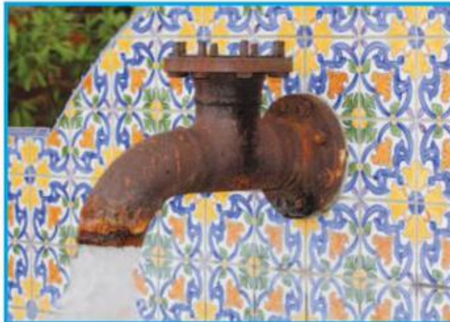
تتآكل بعض الفلزات نتيجة لتفاعلها مع اللافلزات
