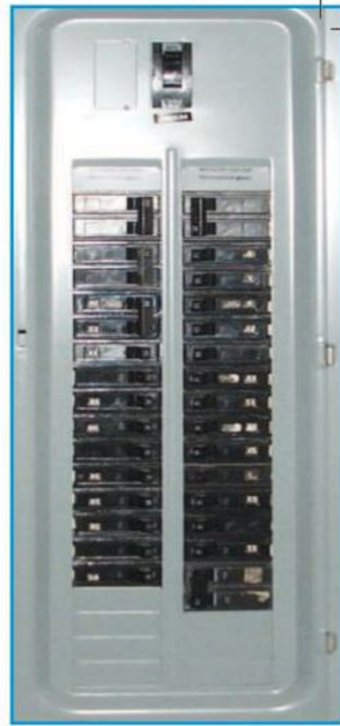
تعمل القواطع على حماية الدوائر الكهربائية من التيارات الكبيرة.
